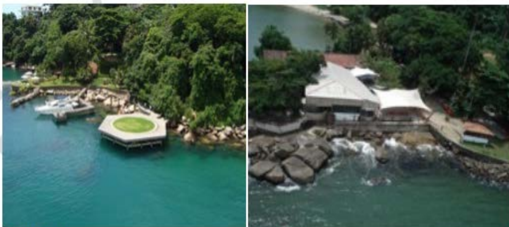
Figura 3.2.2.4-8 – Ocupação desordenada em costões rochosos na APAMLN.
