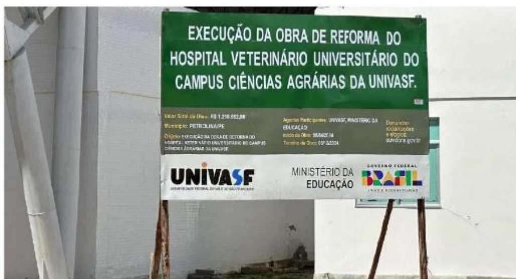
Figura 14 – Placa instalada na entrada do Hospital Veterinário Universitário, sinalizando a realização de obra de reforma do HVU.
